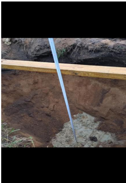
Foto 28. Põhjaveetaseme välja selgitamiseks Arendaja poolt novembri kuu alguses 2024. a. rajatud surf ja põhjaveetaseme mõõtmised.
